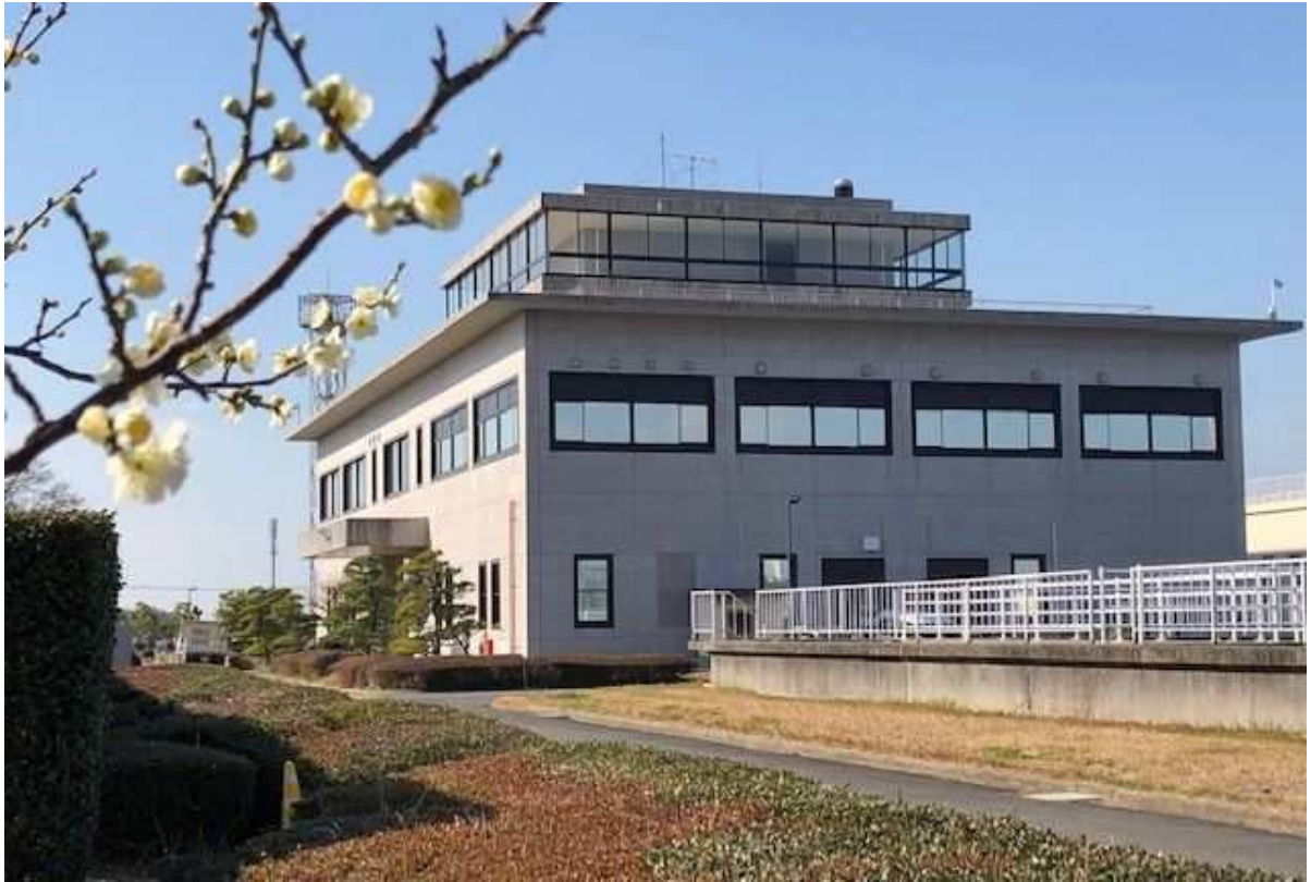
北茂安浄水場
