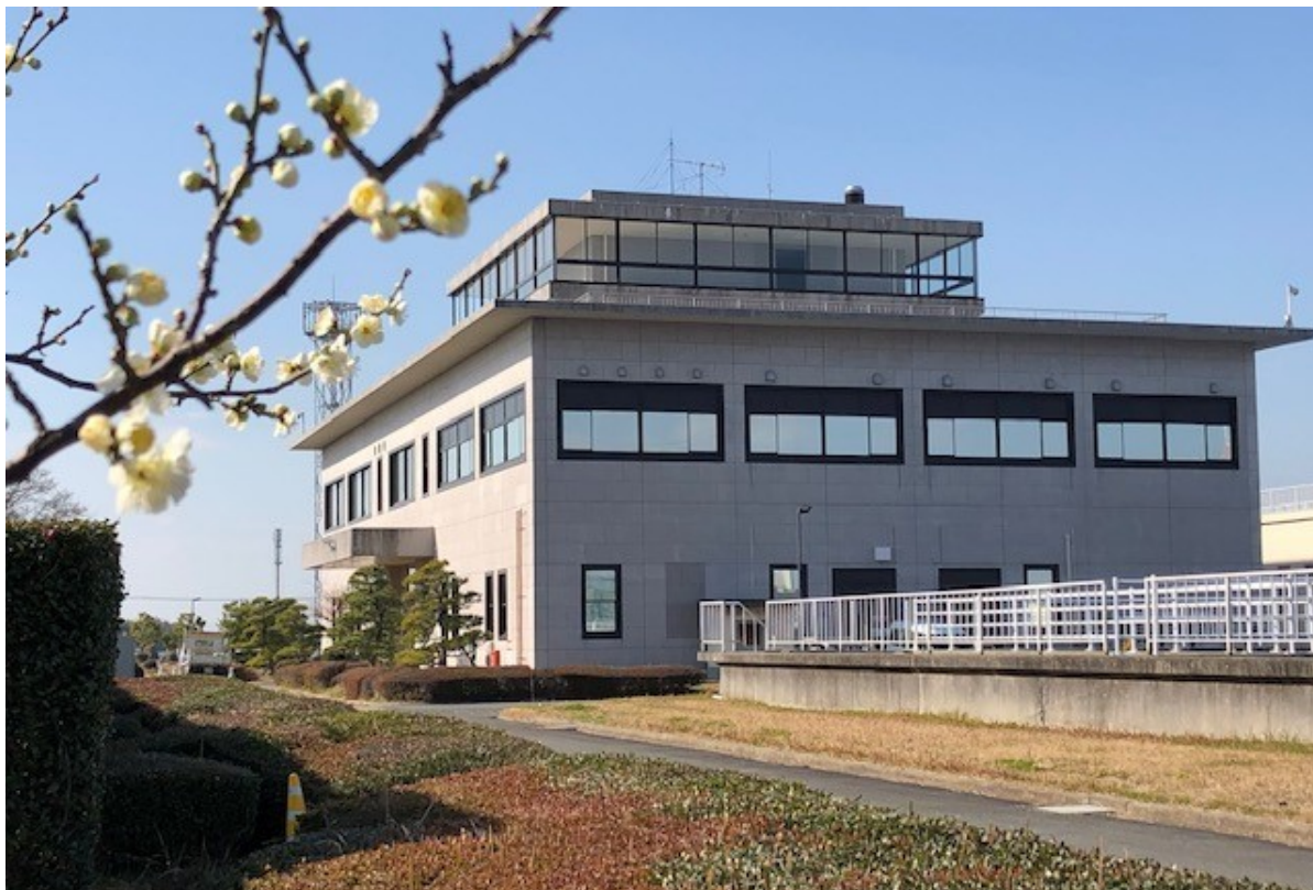
北茂安浄水場
