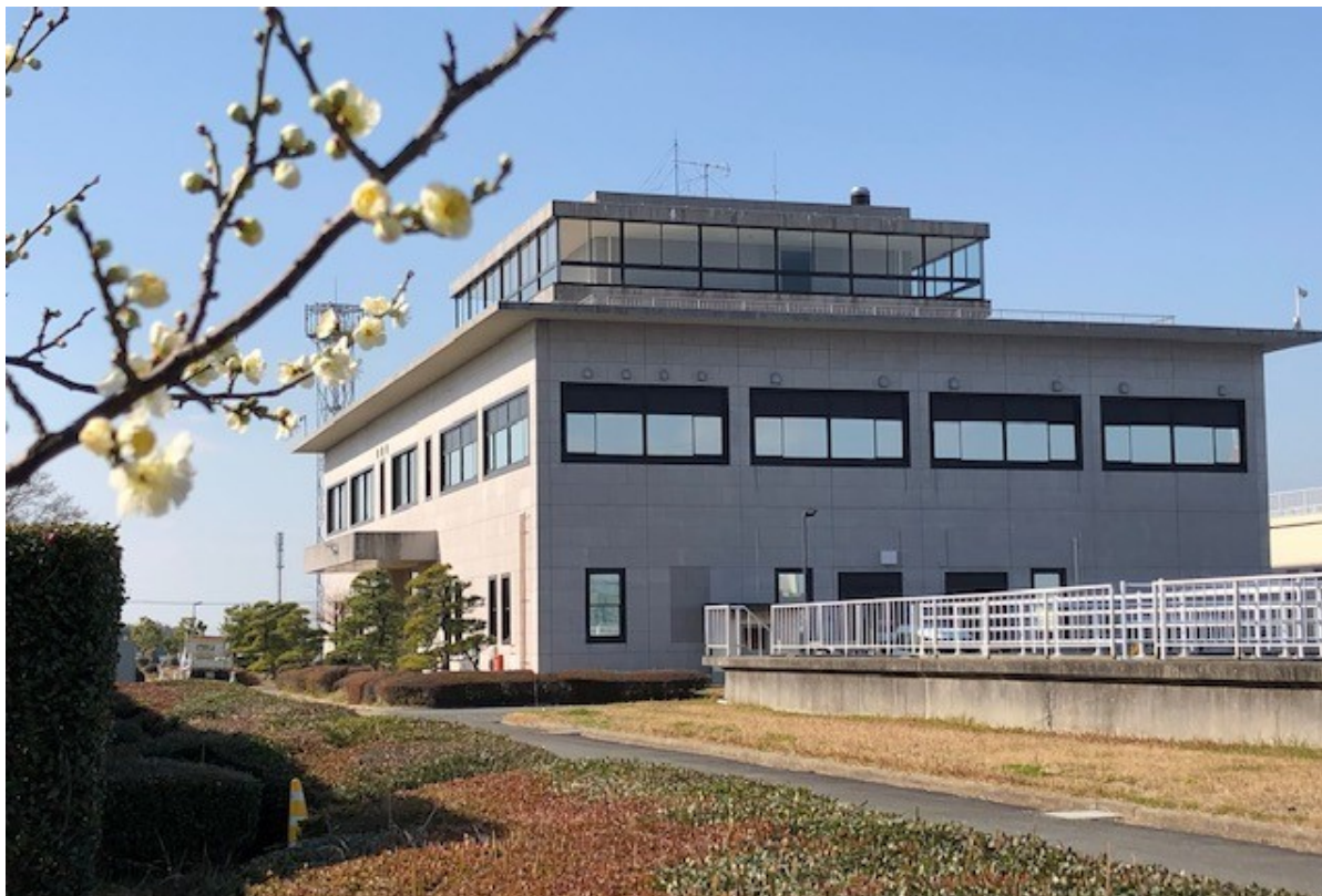
北茂安浄水場
