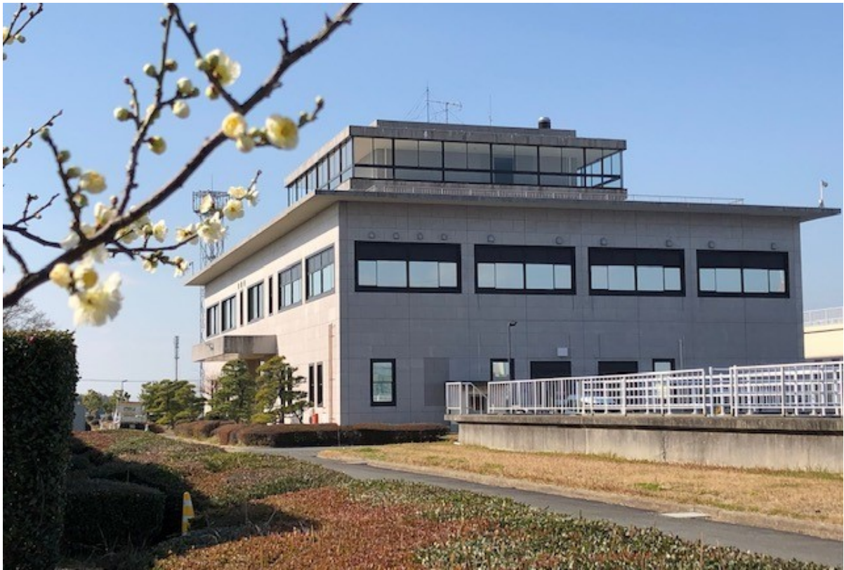
北茂安浄水場
