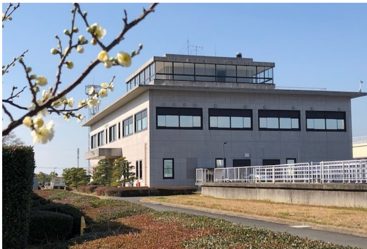
北茂安浄水場
