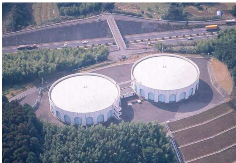
— 中原調整池（三養基郡みやき町） —
