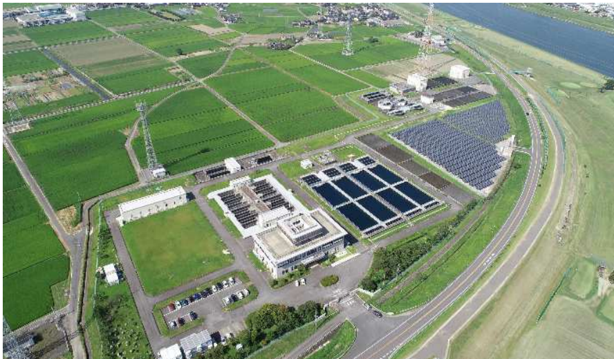
— 北茂安浄水場（三養基郡みやき町） —
