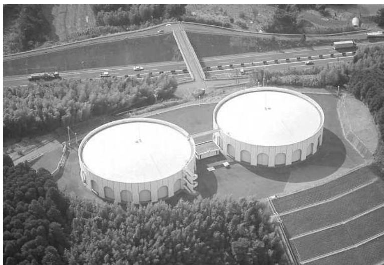
— 中原調整池（三養基郡みやき町） —
