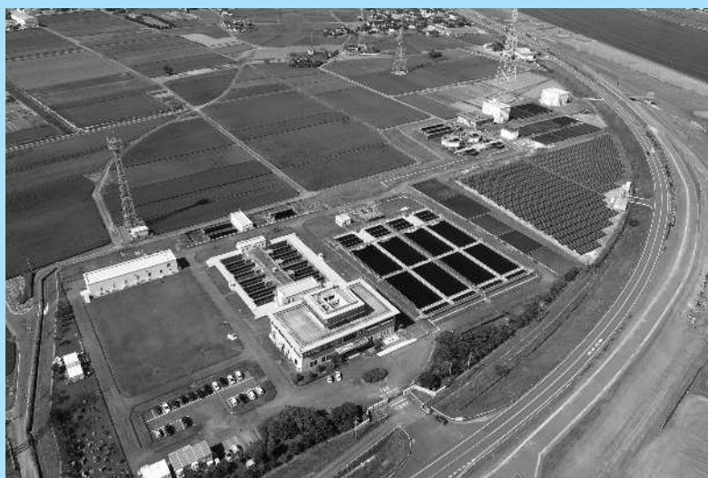
－ 北茂安浄水場（三養基郡みやき町）－
