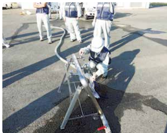
給水タンクを利用した給水の様子
