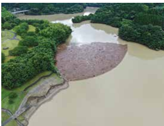
流木が流れ込んだ寺内ダム 写真提供 (独)水資源機構
